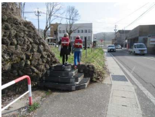
歩道未設置部分(北側)
