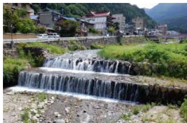
⑪夜間瀬川砂防堰堤 (第26号堰堤)
