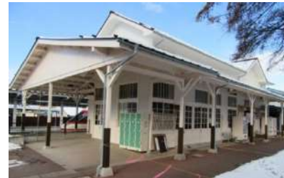
⑫長野電鉄旧湯田中駅舎
