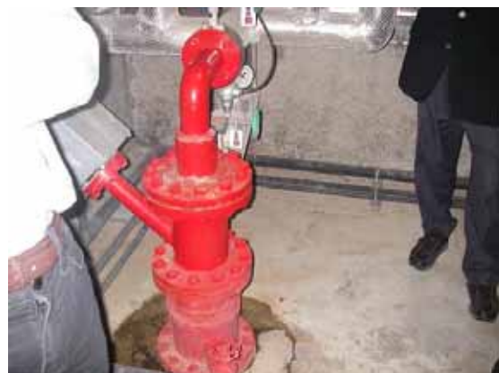
地中熱交換井
