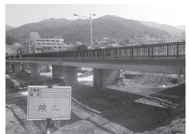
▲栄橋歩道橋補修工事
