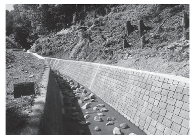
▲伊沢川災害復旧工事
