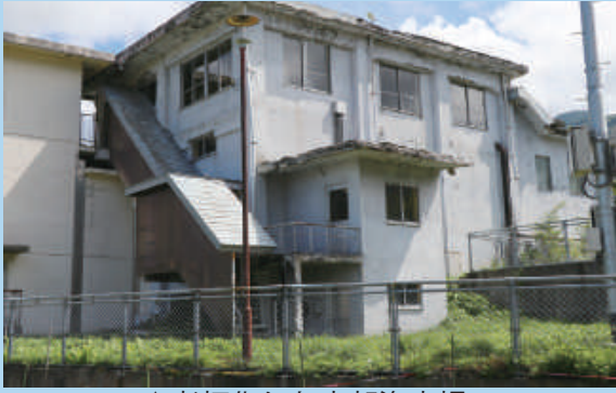
▲老朽化した東部浄水場
