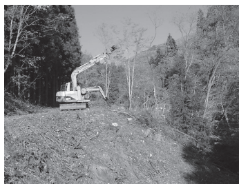
▲チェンソーで切り倒した木をワイヤーロープで引き上げている様子
