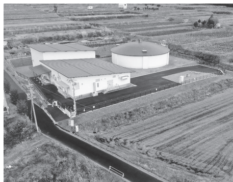
▶ 新東部浄水場全景
