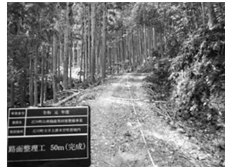
▲作業道修繕の事例
