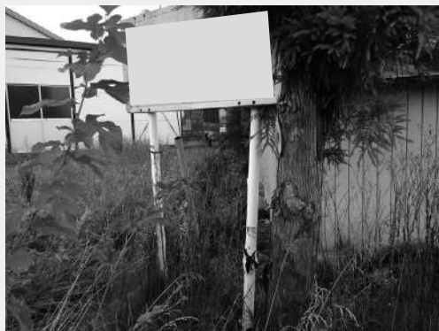
▲ポール部分の破損や錆により倒れる恐れあり
