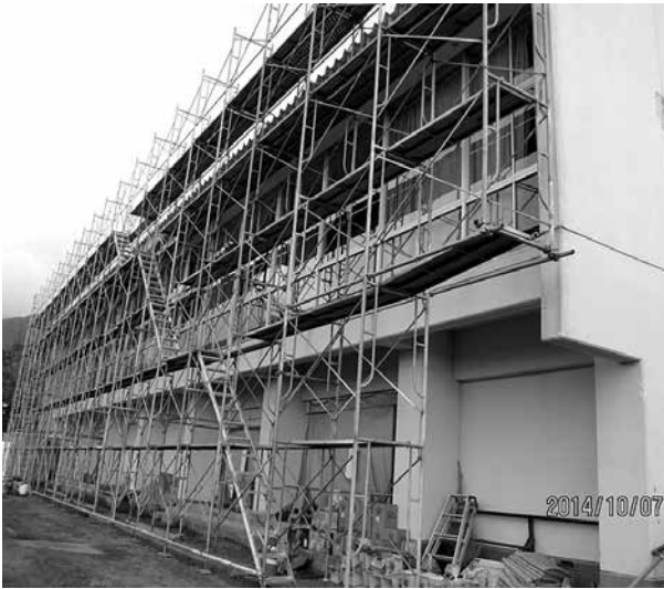
西小学校体育館屋根の塗装工事と修繕工事の現場
