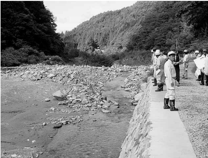
横湯川災害復旧工事現場の視察
