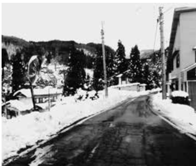
国道403号 最悪狭隘地いよいよ着工
