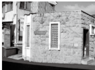
改修される湯田中駅前公衆トイレ
