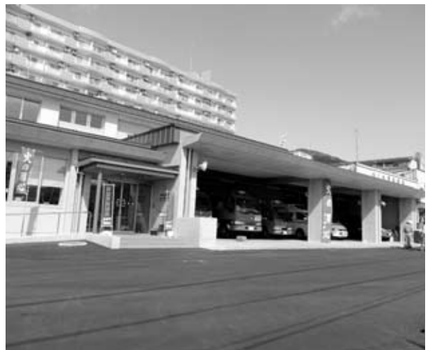
消防団も活用できるスペースを確保した新庁舎
