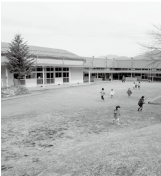
大改修されるほなみ保育園
