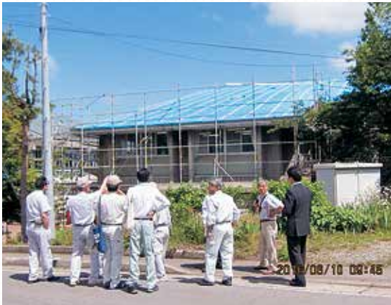
北小学校屋根応急修理状況
