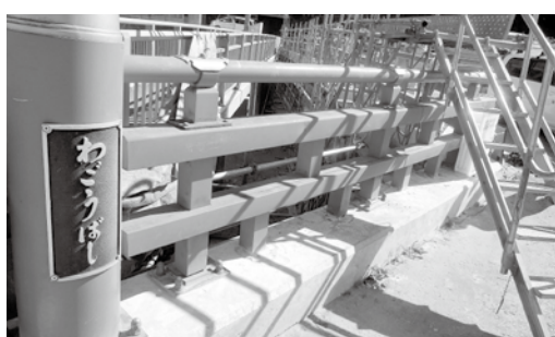
補修工事が始まった和合橋
