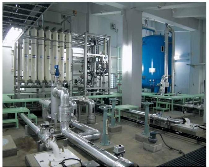
膜ろ過方式を採用し、新たに稼動した南部浄水場
