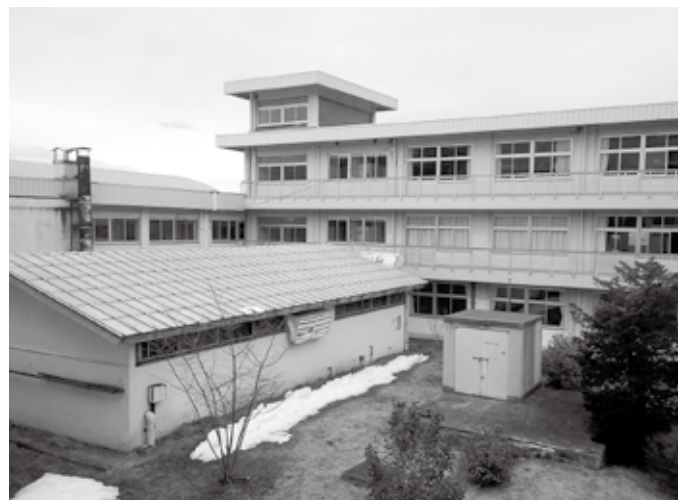
今後3年間で約11億円をかけて長寿命化改修が行われる中学校普通教室棟と管理棟
