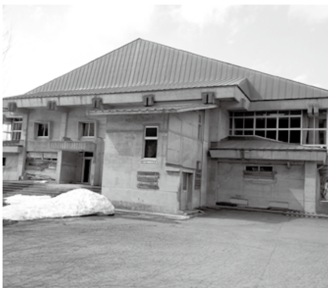
「すがかわ体育館」として社会体育施設となる北小体育館
