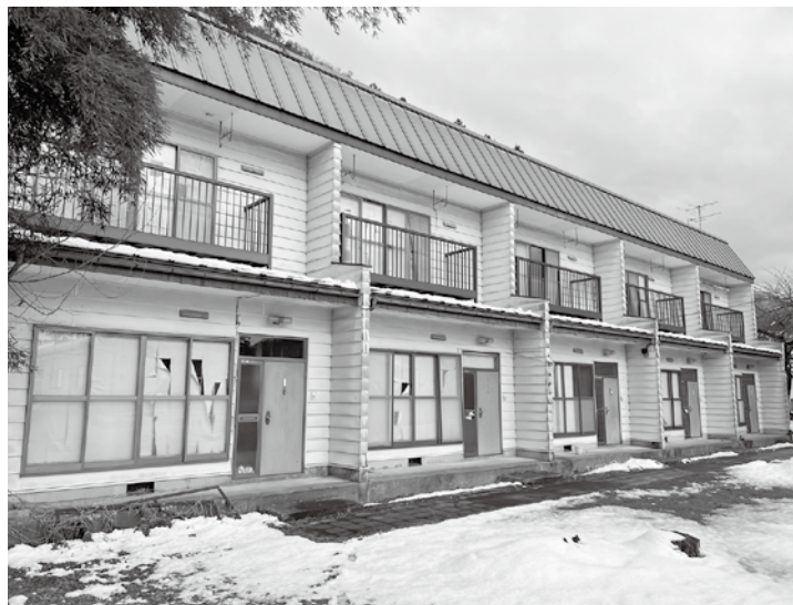
D I Yイベントで移住者向け住宅として活用予定の旧東小教員住宅
