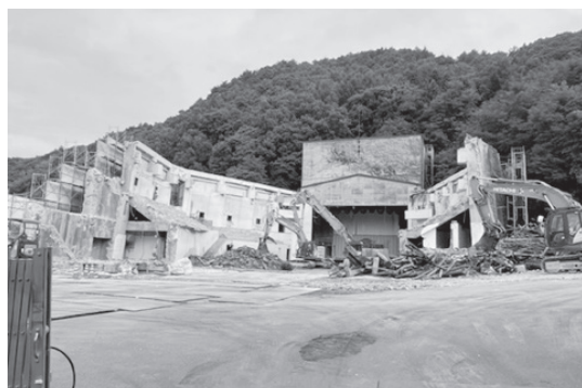
解体中の社会体育館
