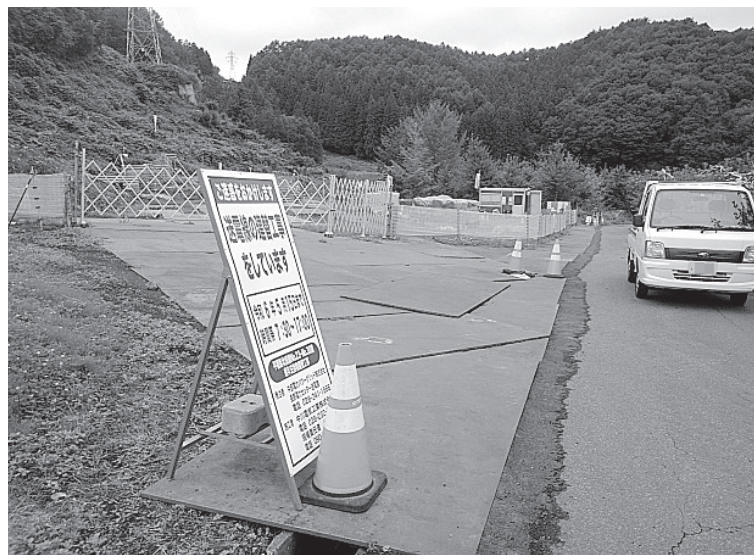
中部電力鉄塔建て替え工事現場
