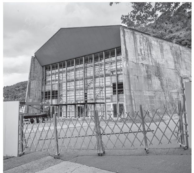
解体工事が始まった社会体育館
