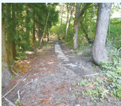
ふたをつけて整備された土橋堰
