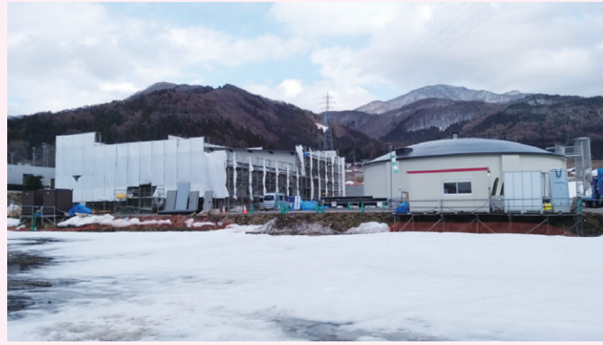
12月しゅん工予定の新東部浄水場
