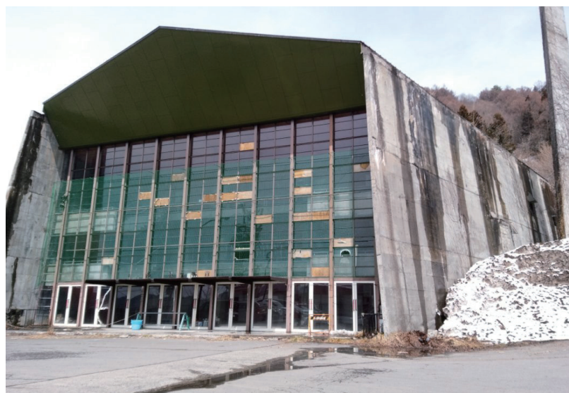
4年度に解体予定の社会体育館
