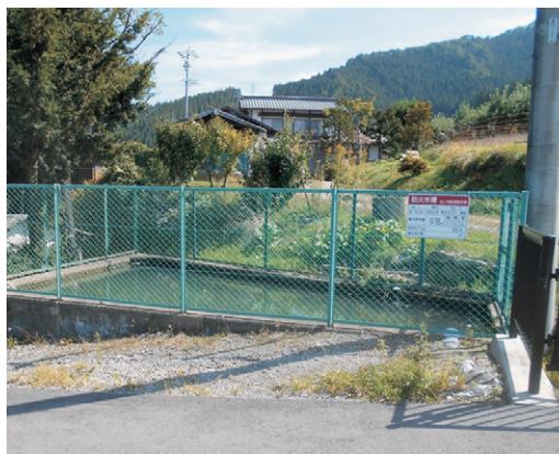
寒沢地区の防火水槽（貯水量約54.8㎡）
