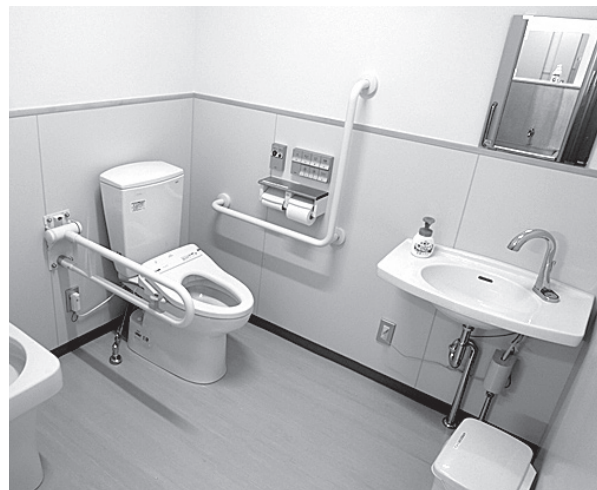
改修された多目的トイレ（南小学校）
