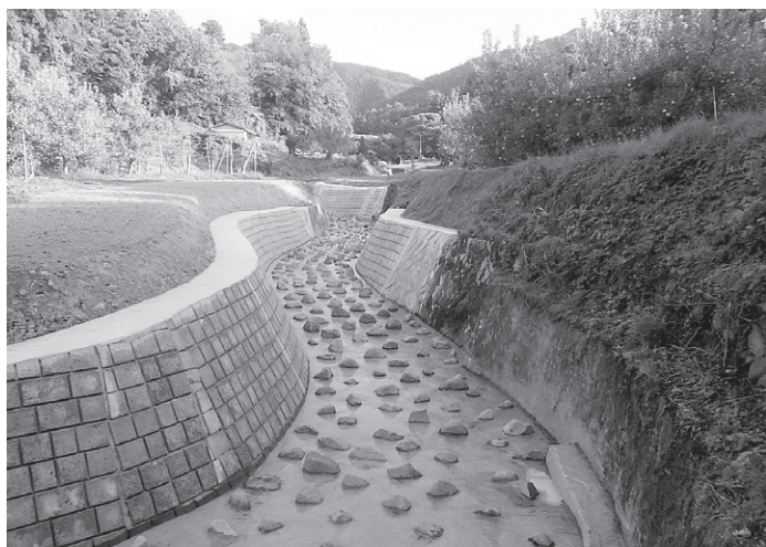
河川災害復旧工事が完成（伊沢川）
