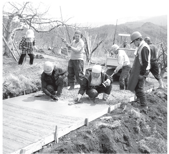
多面的機能支払い交付金事業で農道舗装
