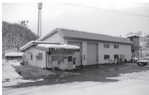
解体される不燃物処理センター
