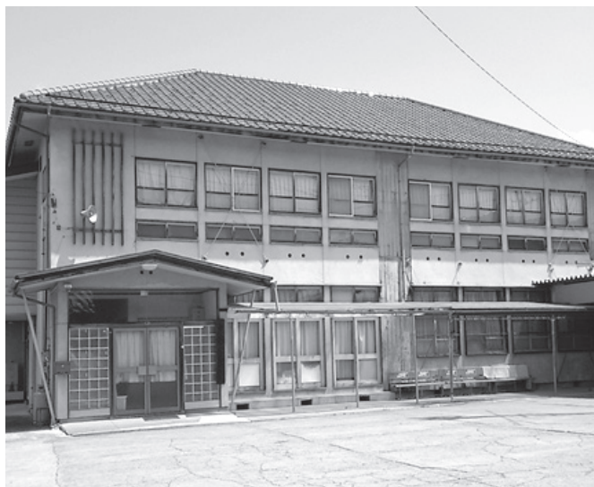
老朽化により改築される戸狩区公会堂 令和2年度コミュニティ助成事業補助金が活用される
