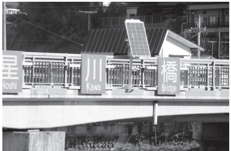
星川橋に設置された、河川監視カメラ 今後の利活用に期待したい。
