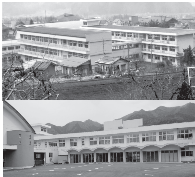
2年におよぶ工事が完了した中学校
