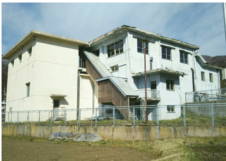
移転して新築される東部浄水場
