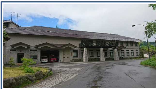
志賀高原総合会館98長寿命化工事確認
