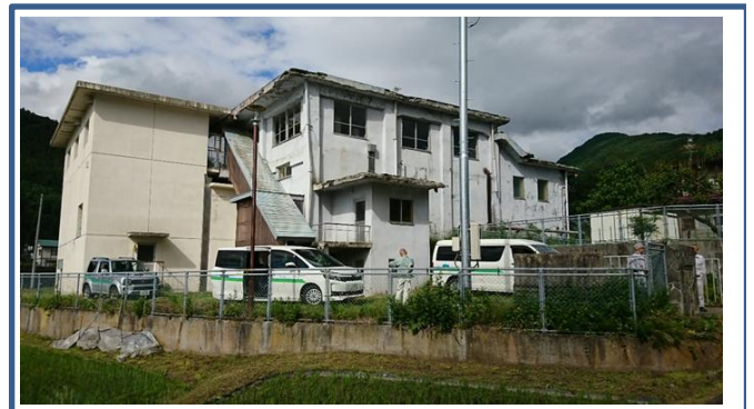
更新工事が待たれる東部浄水場の現状確認
