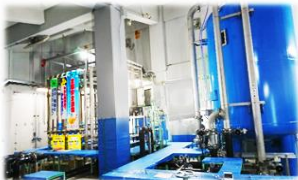
南部浄水場更新工事 新しいシステムの説明を受ける
