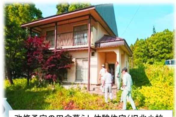
改修予定の田舎暮らし体験住宅(旧北小校 長住宅)
