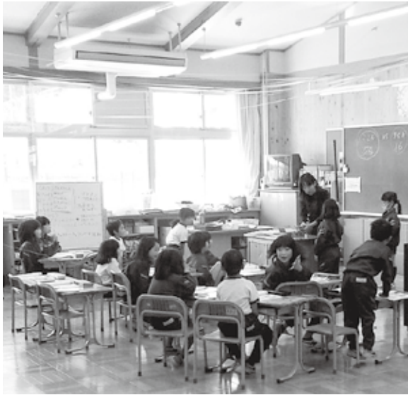
エアコンのある教室 (福島県郡山市湖南小学校)
