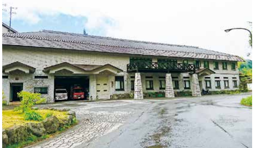
29年度改修工事が行われた志賀高原総合会館98 公共施設の改修・更新・撤去工事が今後も後を絶たない
