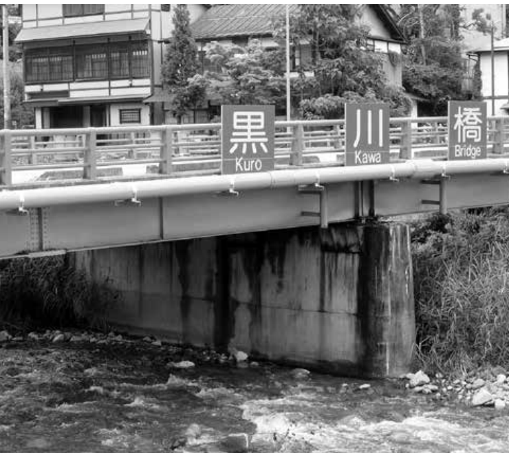
8月下旬から長寿命化工事が着工予定の黒川橋
