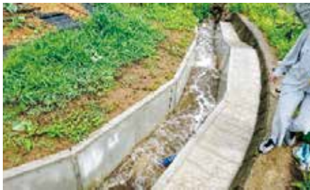
この工事により水路の氾濫が解消される
