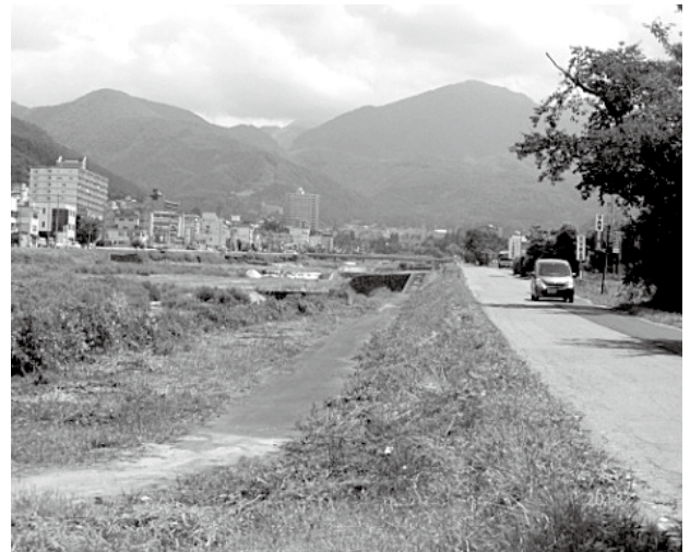
左岸道路、ハンドル操作を誤れば転落の危険
