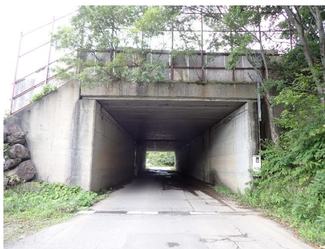
東館トンネル
