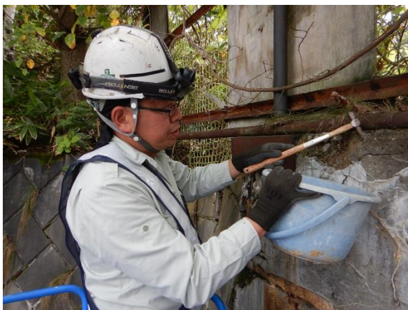
応急処置(たたき落とし)状況
