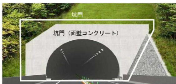
トンネル坑口部
