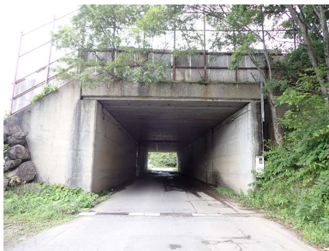
東館トンネル
