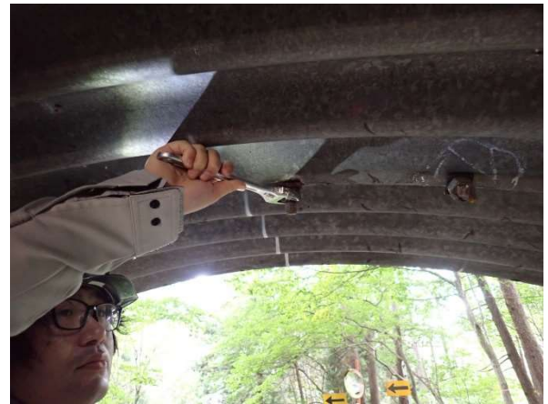
応急処置(ボルト締付)状況
