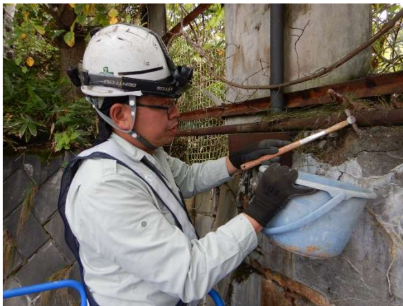
応急処置(たたき落とし)状況
