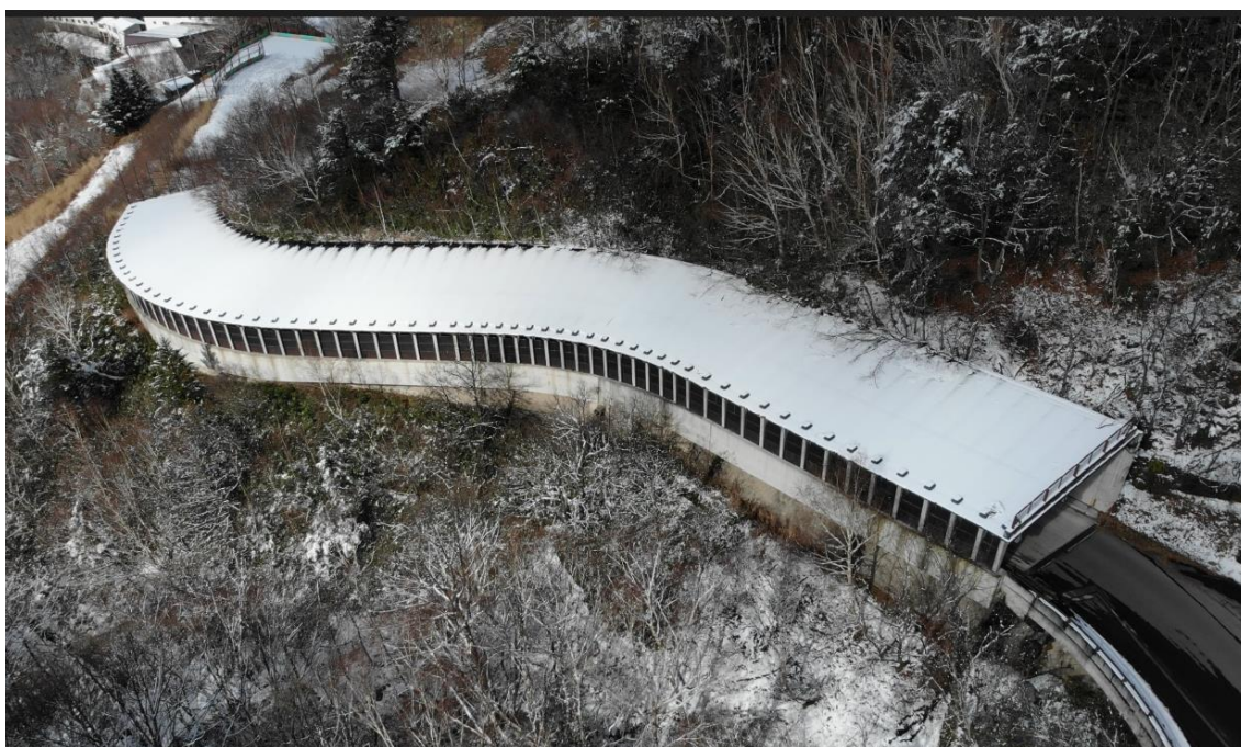
発哺スノーシェッド ドローンより撮影
